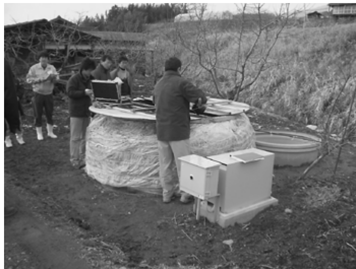
簡易曝気処理槽とブローワー(手前)
