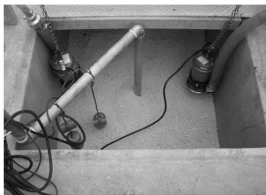
図3 パーライト型硫黄脱窒資材を利用した脱窒装置の例
