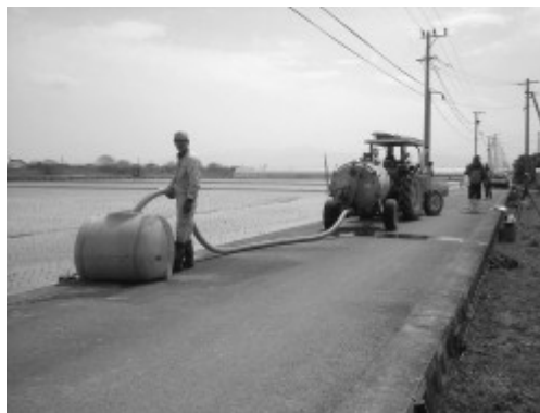
写真5 バキュームカーを使った補給
