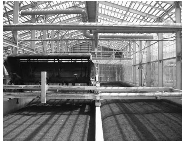
写真5 ロータリー攪拌式牛ふん発酵槽
