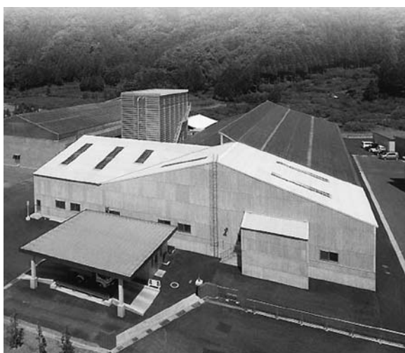
写真1 堆肥化施設全景
