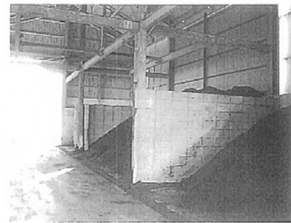
写真5 堆肥製品置場
