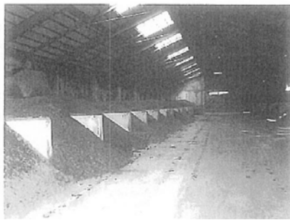
写真3 堆肥化処理施設内部
