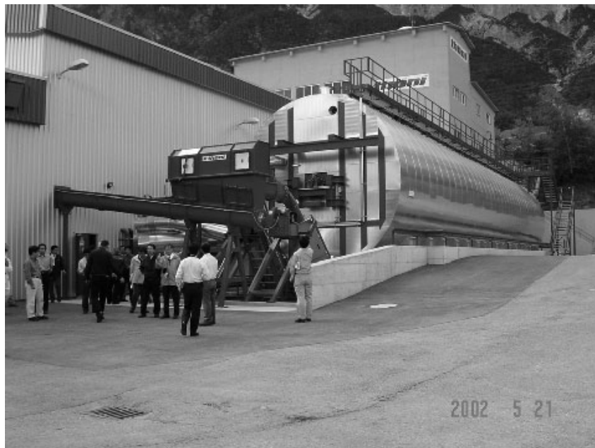
写真2 乾式メタン発酵槽
