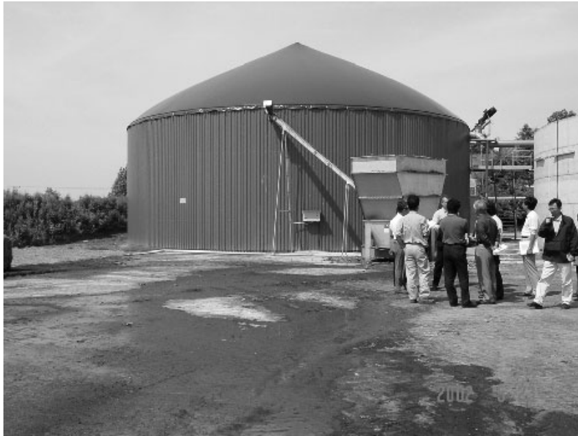
写真5 家畜ふん尿、農作物残渣(じゃがいも等)を処理する中規模のバイオガスプラント
