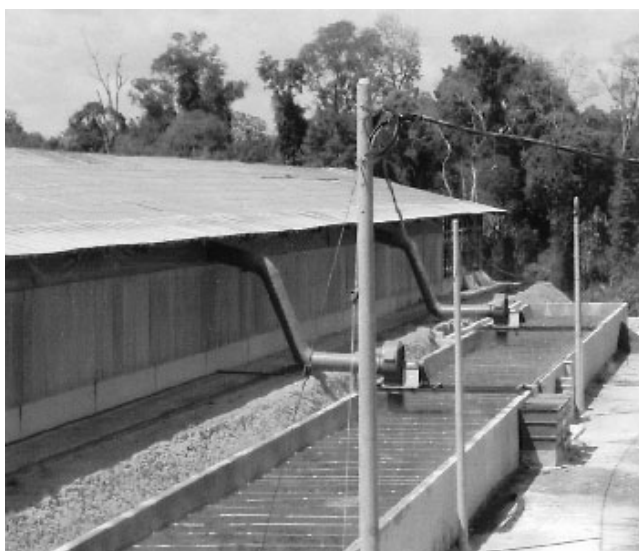
脱臭装置 (微生物脱臭装置、上部より散水装置完備)
