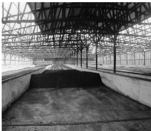
発酵棟の内部 (間口40m、長さ80mの建物の中で6槽の発酵槽、 発酵機はD1000?6型、1台で3槽を自動攪拌)
