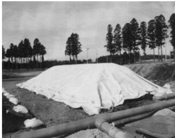
写真1 シートを利用した簡易ふん尿処理施設
