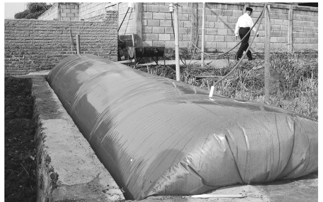
メタンガスをためているビニール
