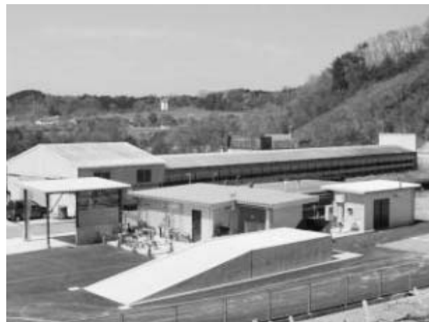
バイオガス発電実証展示施設
