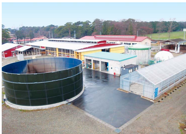
バイオガスプラントとフリーストール牛舎 (プラントの経済性、エネルギー回収効率、環境影響等について研究を進めています。)
