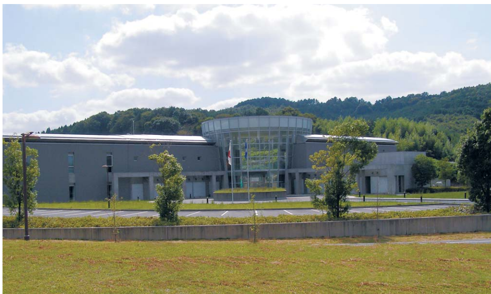
畜産センター本館
