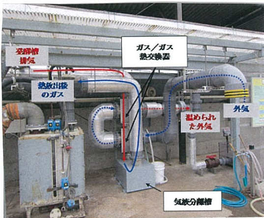
図1 クロスパイル式熱交換器の外観
