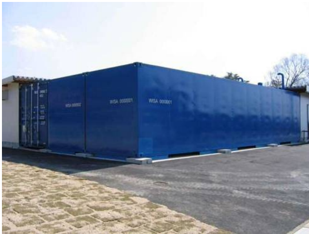
参考 写真1 畜産バイオマス利活用実証展示施設 メタン発酵槽
