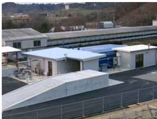
写真4 畜産バイオマス利活用実証展示施設
