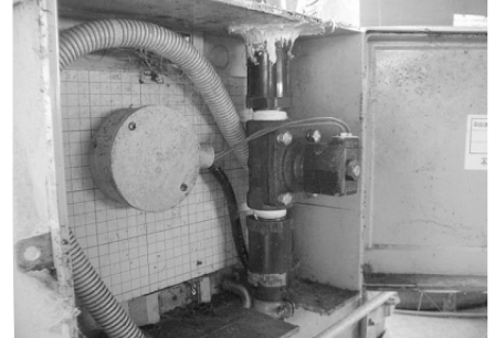
【電磁弁でエアリフトポンプを制御】
