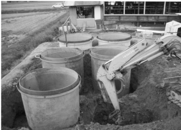
【曝気槽の埋設工事】
