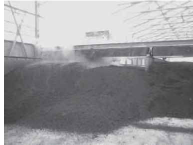
2次発酵処理（攪拌機）
