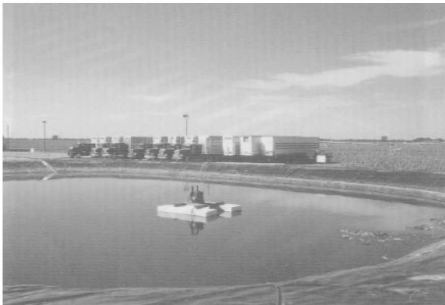
写真2 出荷用トレーラー洗車場のラグーン 黒いゴムマットが敷かれている。
