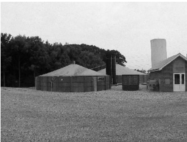
写真2 Lundsby Bioenergi社製個別型バイオガスプラント。左が前処理槽400m 3 で奥が発酵槽13000m 3 。その間にある黒い縦型のタンクは脱硫槽で、右の白い縦型のタンクにはお湯が貯留してある。右の建物に制御装置、発電機、ポンプ等が集中して入っている。
