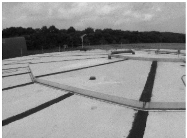
写真3 DDH Contractors A/S社製の個別型バイオガスプラントの特徴的な形をしたタンク。外側から発酵槽、前処理槽、有機性廃棄物の貯留槽が配置されている。
