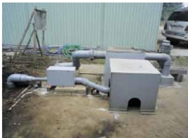
酪農家稼働中の空気エゼクタの原理を利用した臭気搬送装置
