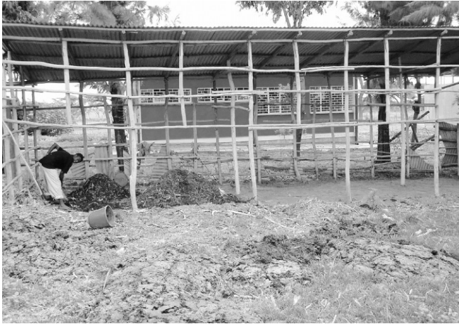
試験的堆肥製造のために造られた簡易堆肥舎 (ATARC)
