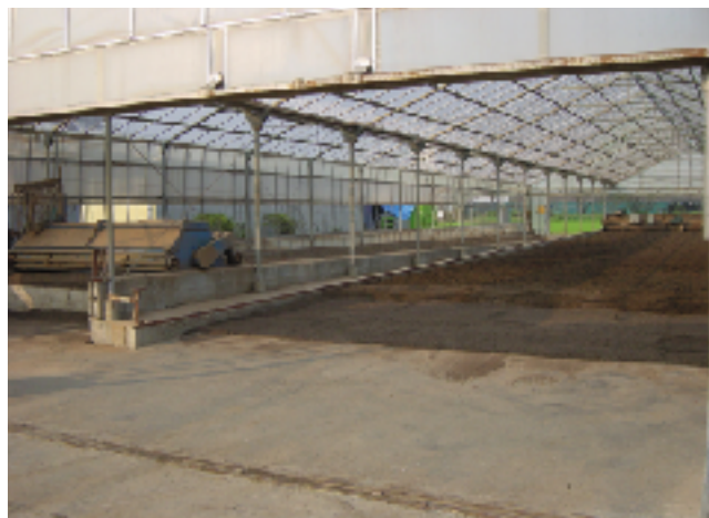
製品堆肥を副資材に利用する 複列発酵乾燥ハウス
