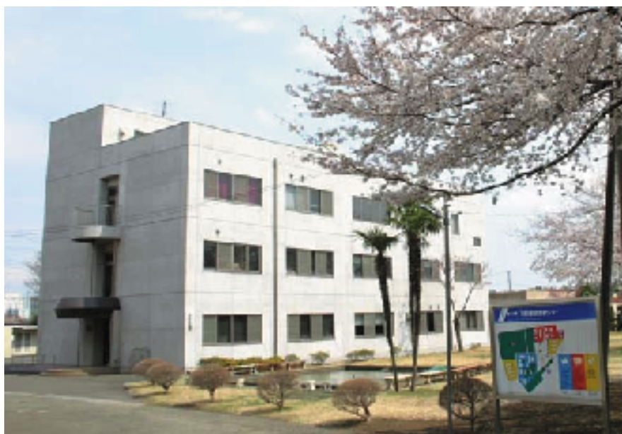
神奈川県畜産技術センター 総合研究棟
