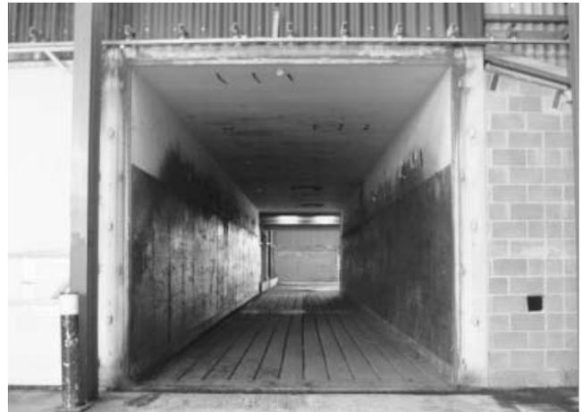
図4 トンネル型発酵槽の扉を開けたところ
