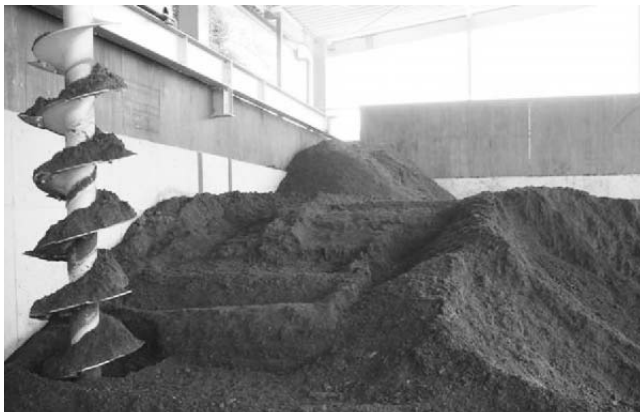
写真3 攪拌・発酵処理
