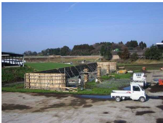
写真1 新たに整備中の処理施設
