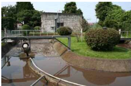
写真1 家畜用浄化槽(神奈川方式)
