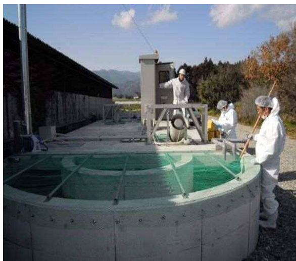
写真1 低負荷回分式活性汚泥施設の導入
