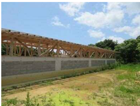
写真2 堆肥保管施設(外観)
